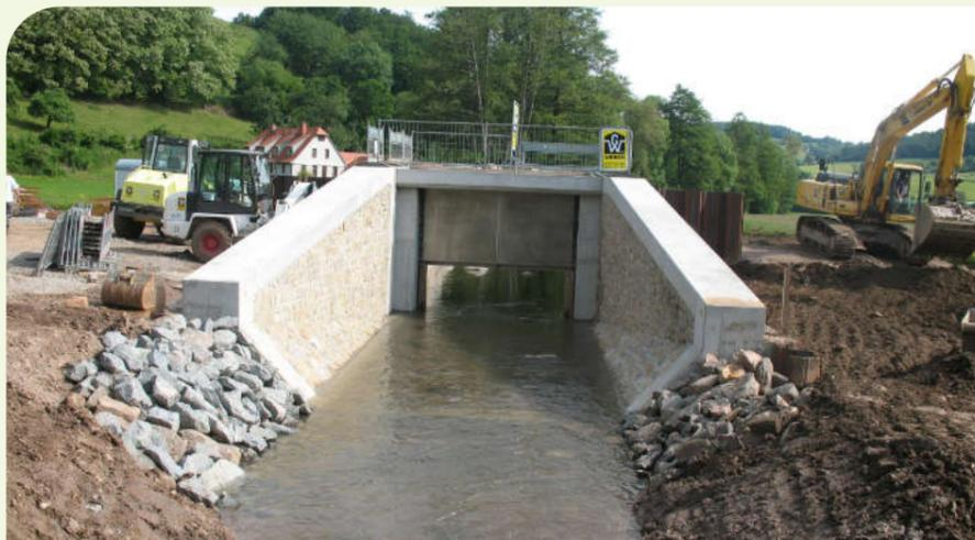
Im Mai 2009 wurde in Bockenrod das Rolltor montiert und der Durchlass verkleidet.
