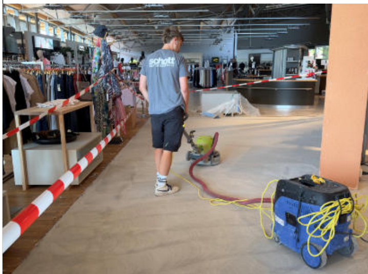
Bei laufendem Geschäftsbetrieb werden die Räumlichkeiten von Mode Zörgiebel zukunftsweisend modernisiert. Foto: Arnold Zörgiebel
